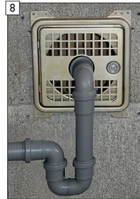
8 Kondensatableitung zum Abwasserkanal bauseits herstellen (HT-Rohr DN40 bauseits bereitstellen).
