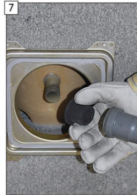
7 Anschlussübergang von HT DN40 auf den Kondensatablauf des Sockelsteins erfolgt mit einem Adaptergummi.
