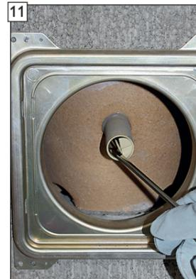
11 Verschluss am Kondensatablauf des Sockelsteins herausbrechen.
