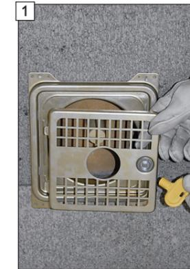
1 Zulufttürblatt mit PT-Schlüssel öffnen und aushängen.
