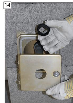
14 Die Abdichtung des BlowerDoor-Türblattes zum HT-Rohr kann mit einem Dichtgummi 40/50 erfolgen.
