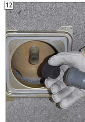
12 Anschlussübergang von HT DN40 auf den Kondensatablauf des Sockelsteins erfolgt mit einem Adaptergummi.
