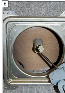
6 Verschluss am Kondensatablauf des Sockelsteins herausbrechen.
